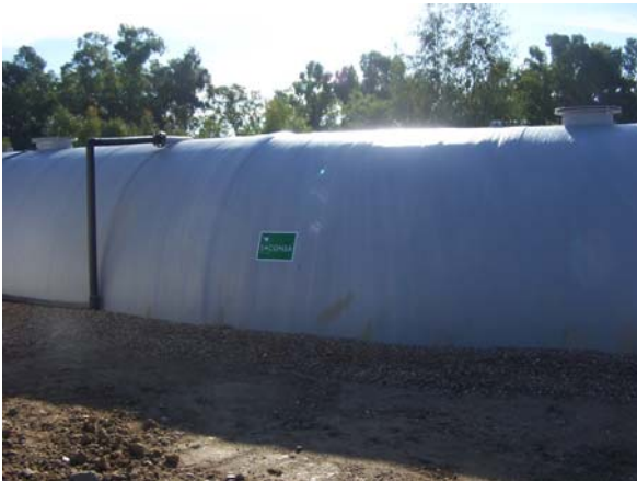
DEPÓSITO DE ALMACENAMIENTO DE AGUA DEPURADA
